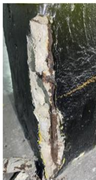
Pilar corroído na região térrea dos transpasses
