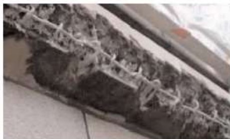
Protecção anti-corrosão activa com Emaco
