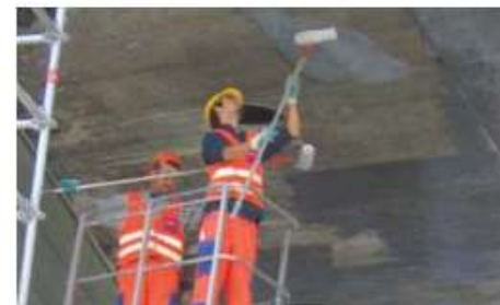
Tratamento hidrofóbico utilizando Masterseal 303.
