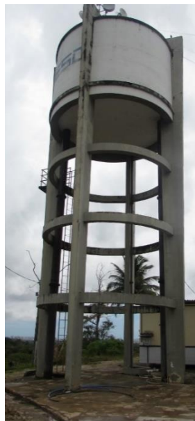
Figura 6: Reservatório elevado de água – São Cristóvão/SE
