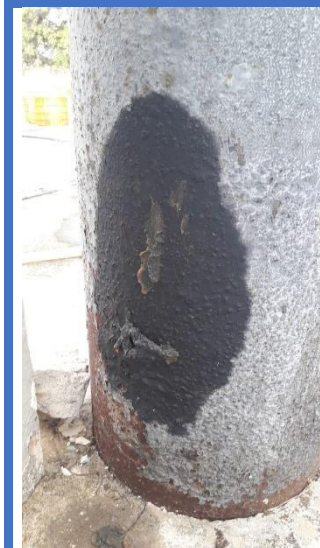
Vazamento em tubulação metálica
