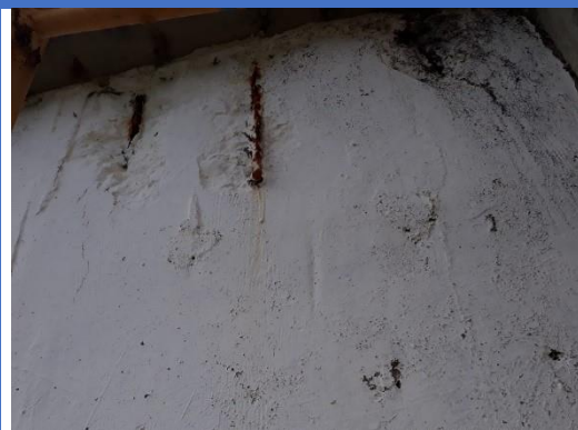
Armadura exposta e cobrimento inferior
