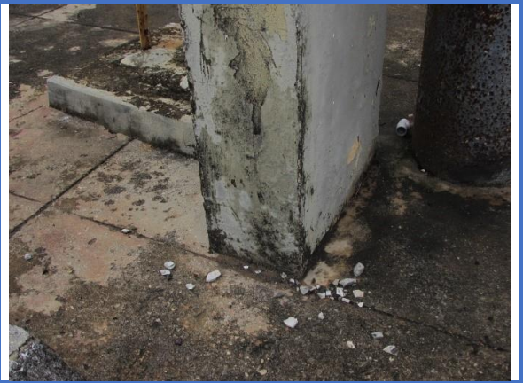
Umidade em pé de pilar
