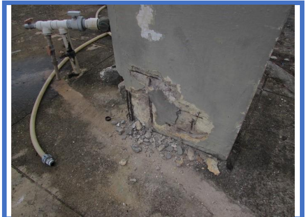
Deslocamento de concreto de cobertura
