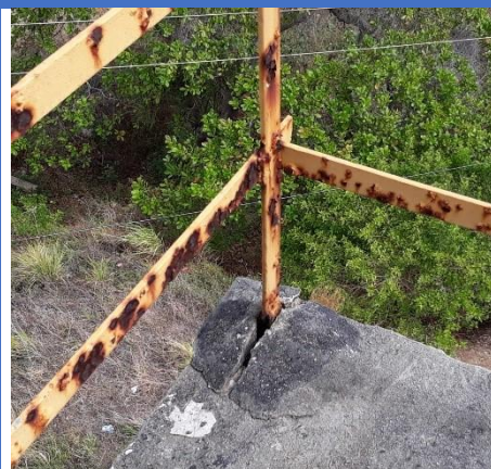
Parte da escada de acesso
