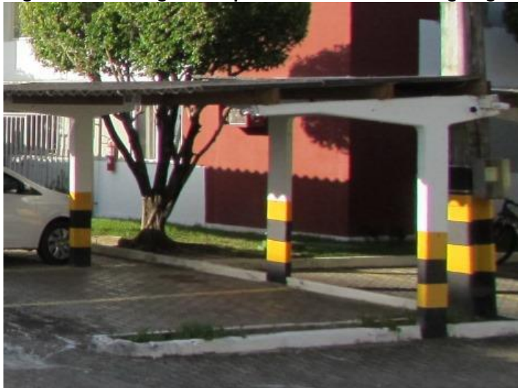
Figura 15 – Vista geral do pilarete da cobertura da garagem
