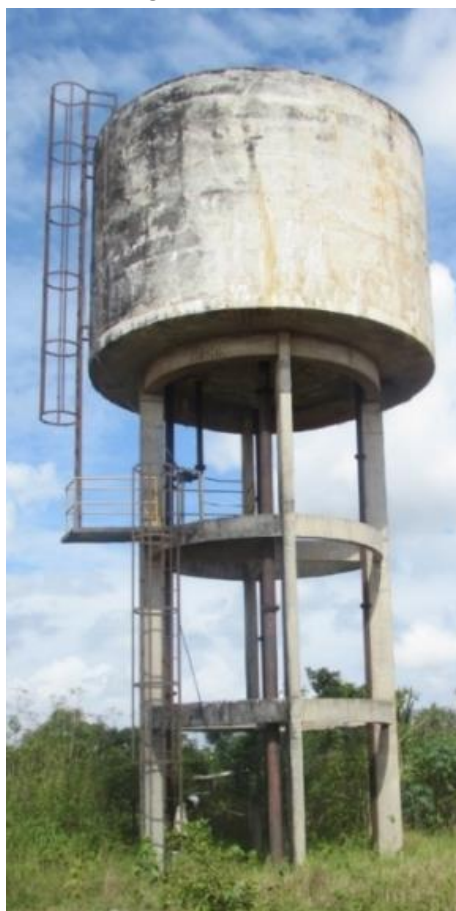
Figura 10 – Vista geral do reservatório elevado A
